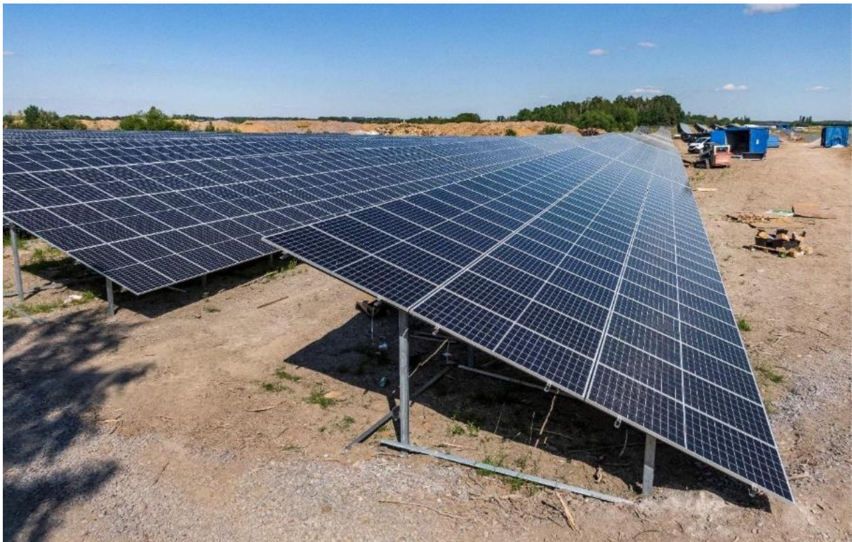
Figur 3. Stativ/bord med solpaneler. Bildkälla: Alight AB.
