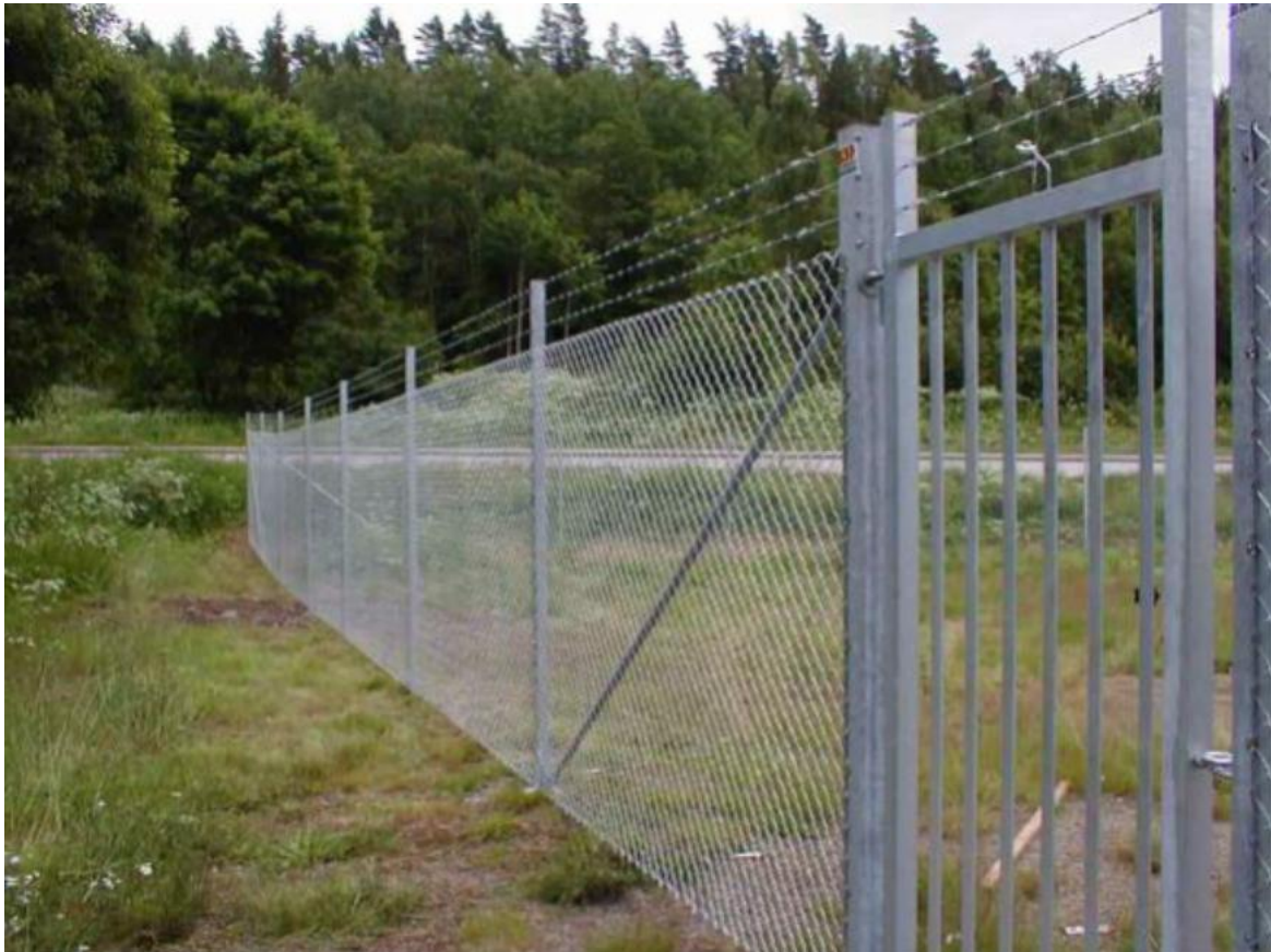
Figur 8. Industristängsel, ca 2,45 m högt.
